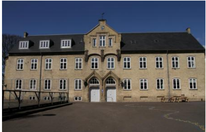
Gymnastiksalsbygningen til Jonstrup Gamle Seminarium 1889.
